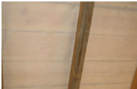
**2. Для утепления мансард используются теплоизоляционные плиты ЛАЙТ БАТТС™ или ЛАЙТ БАТТС К™. Плиты поставляются в полиэтиленовой упаковке. Перед монтажом теплоизоляцию необходимо распаковать, разрезав упаковку ножом.**
