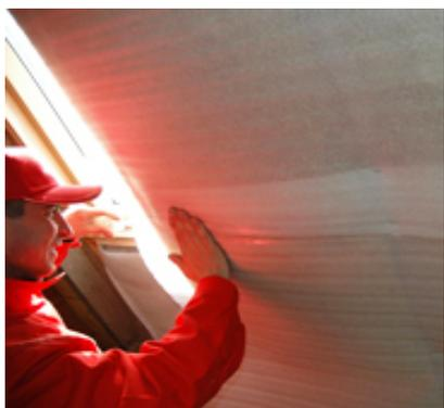
**10. После того, как смонтирована пароизоляционная пленка, к лагам прибиваются горизонтальные бруски с шагом 50 см, которые дополнительно фиксируют теплоизоляционный слой и служат для формирования воздушной прослойки между пароизоляцией и внутренней обшивкой, которая необходима для удаления влаги с поверхности пленки. К брускам саморезами прикручивается внутренняя обшивка.**
