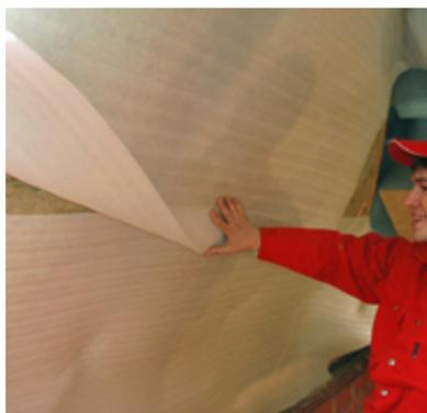
**9. Полотнища пароизоляции устанавливаются с перехлестом 10 см и склеиваются специальной лентой типа скотч. Эффективным является использование фольгированных пароизоляционных пленок, которые не только являются барьером для диффундирующей из внутренних помещений влаги, но и материалом, отражающим поток лучистого тепла назад в помещение.**
