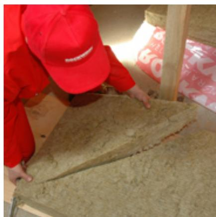
**4. Расстояние между осями стропил должно равняться ширине теплоизоляционной плиты. При соблюдении этого условия благодаря упругим свойствам плит Лайт Баттс утеплитель будет установлен враспор между стропилами, чем обеспечивается плотное примыкание теплоизоляции к стропилам.**
