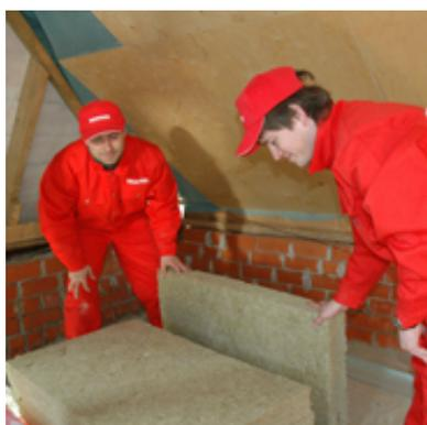
**3. Благодаря высокой плотности материала ( $37 \text{ кг/м}^3$ ) он легко разрезается ножом. Для подрезки плит необходимо использовать нож с длиной лезвия большей, чем толщина материала. Ломать или рвать плиты не допускается.**
