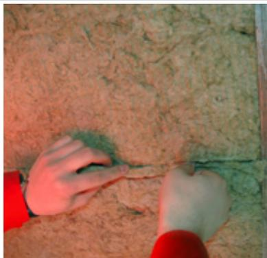
**8. После того, как вся теплоизоляция будет установлена в проектное положение, производится монтаж пароизоляции. Пленка натягивается поверх утеплителя и прибивается степлером к стропилам.**
