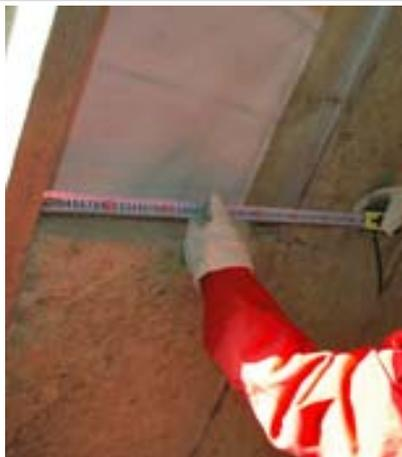
**5. Монтаж необходимо вести снизу вверх, плотно прижимая теплоизоляционные плиты друг к другу. Такой порядок монтажа поможет избежать щелей между плитами, которые приводят к промерзанию, и как следствие, образованию наледей на поверхности кровли. При устройстве теплоизоляции в два слоя необходимо обеспечить перекрытие швов нижнего слоя плитами верхнего слоя, т.е. устанавливать плиты в разбежку.**
