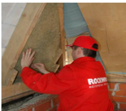
**7. После того, как вся теплоизоляция будет смонтирована, необходимо внимательно проверить все стыки между теплоизоляционными плитами и стропилами. В случае обнаружения щелей их необходимо заделать тем же материалом на всю толщину теплоизоляции. Для этого ножом вырезается элемент имеющий размеры по ширине и длине на 1 см больше чем размеры щели и в распор устанавливается в щель.**
